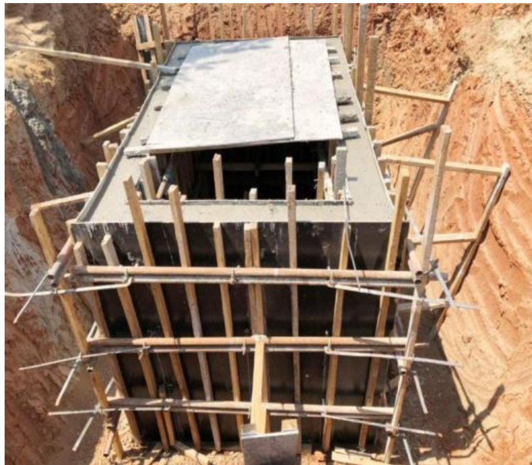
混凝土直线井支模浇筑图
