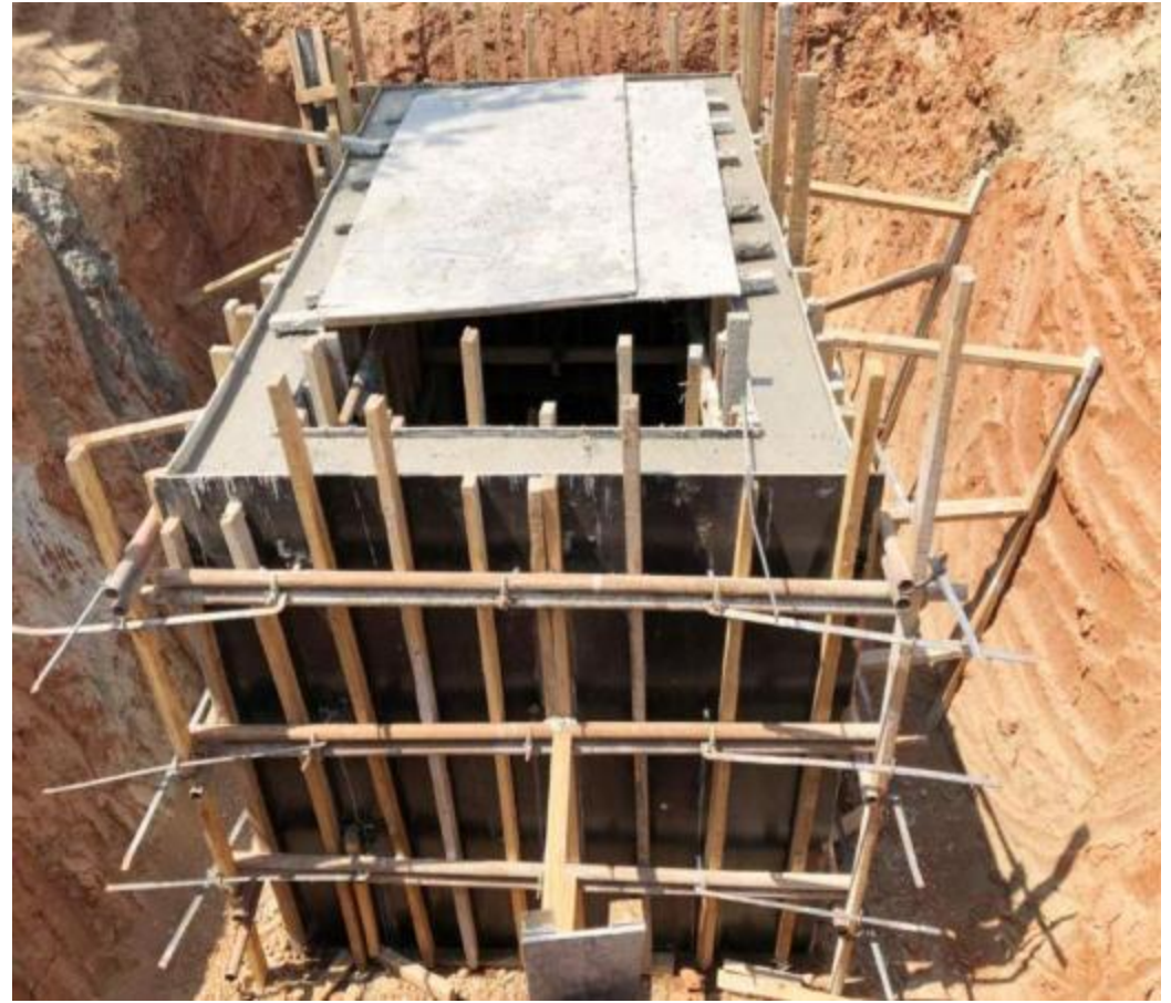
混凝土直线井支模浇筑图
