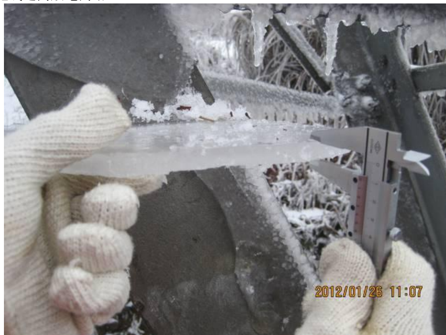
图 X 导线脱落覆冰照片（样图）
