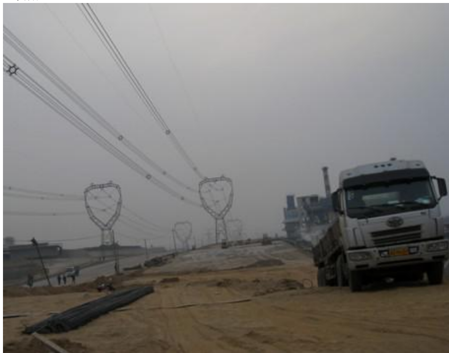
图 X XXXX（施工现场照片）
