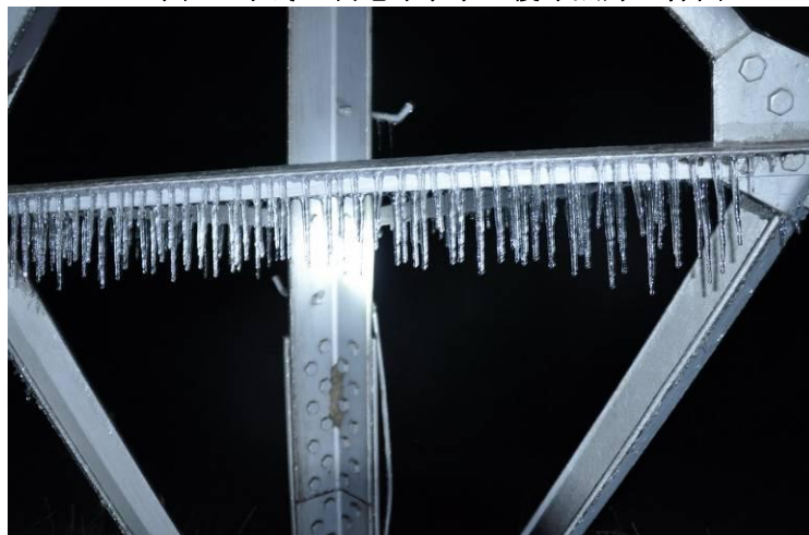
图 X 杆塔覆冰照片（样图）
