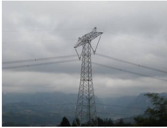
图 X XXXX (现场地形情况说明照片)(坡度大且为峡谷大沟地形样图)
