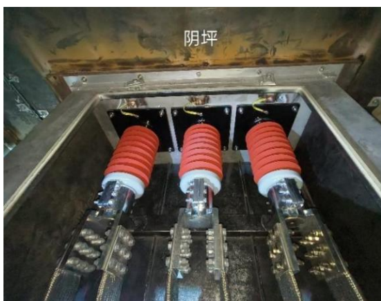
图 8 共箱母线箱体内外封堵
