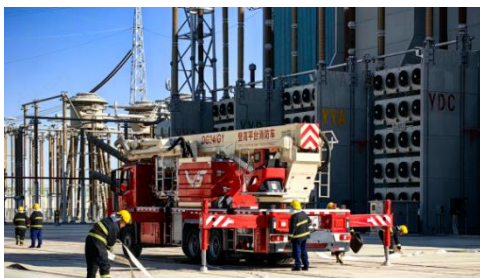
图 12 ±800 千伏祁连换流站消防演练执行记录
