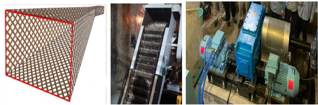
图 8 拦截体系提升（左：网兜式拦污网；中：自动清理除污机；右：鼓网电机优化）
