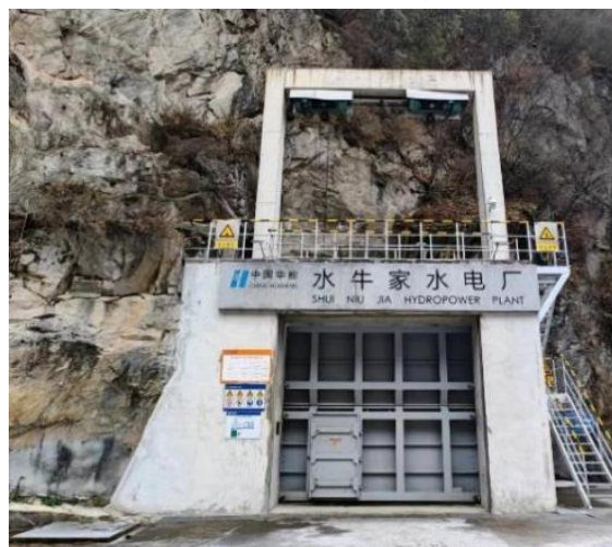
图 3 水牛家电站进厂交通洞防洪设施
