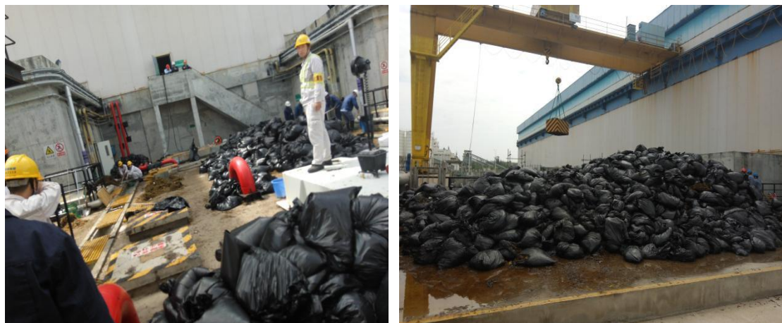
2016年10月19日，受台风“莎莉嘉”影响，冷源系统取水明渠进入大量生活垃圾、海生物等杂物，造成鼓网堵塞并最终导致汽轮机跳闸、反应堆停堆。
