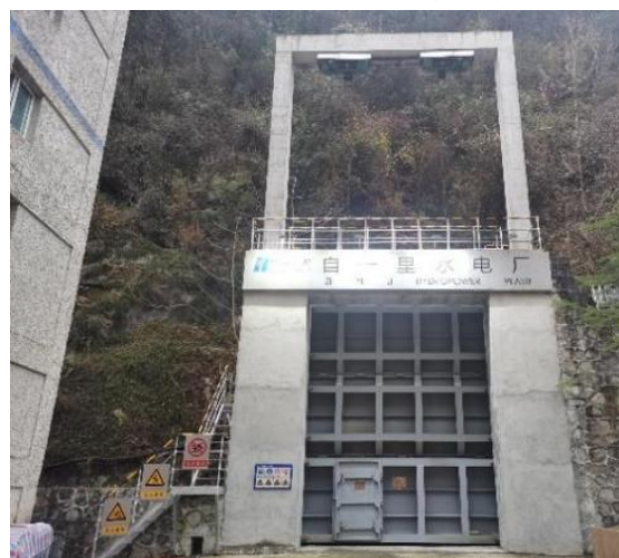
图 4 自一里电站进厂交通洞防洪设施
