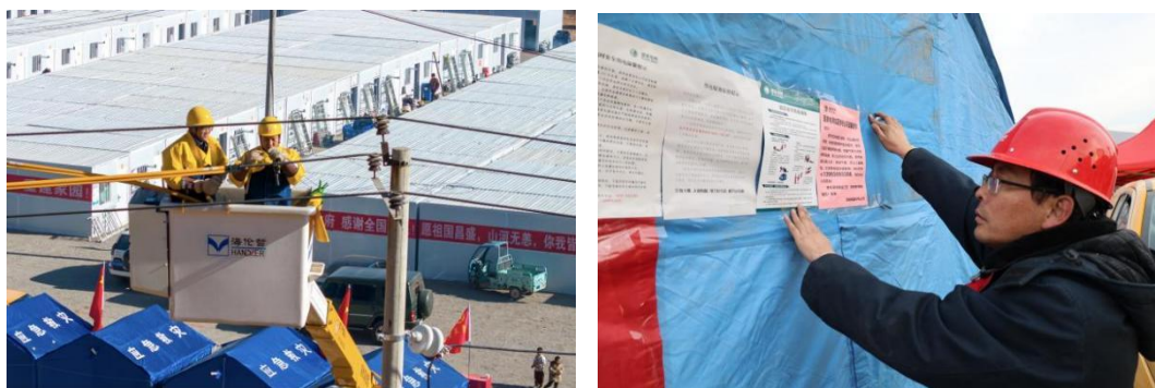
图3 全力抢修电力基础设施
