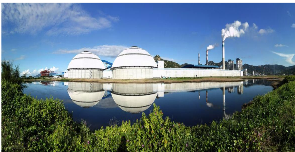
图 5 国能台山电厂圆形煤场和防风抑尘网
