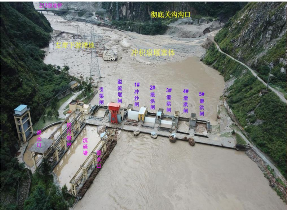
图1 华能太平驿水电站“8·20”泥石流灾害情况
