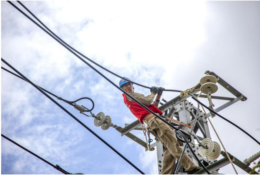
图 6 电力杆塔上抢修作业
