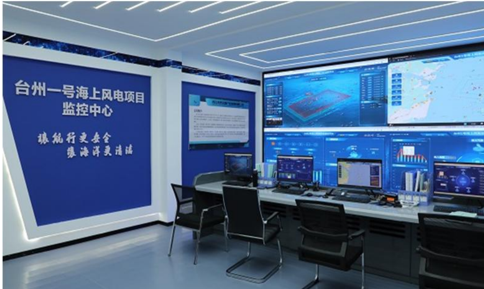
图 2 海上风电项目监控中心
