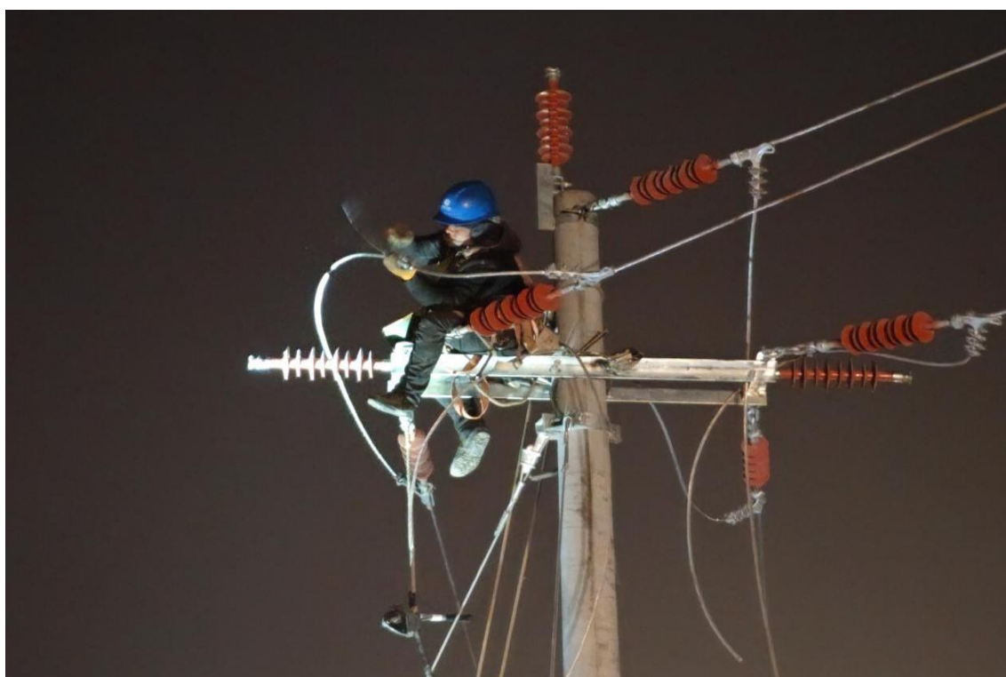
图 4 国网新疆电力有限公司开展输电线路震后抢修恢复
