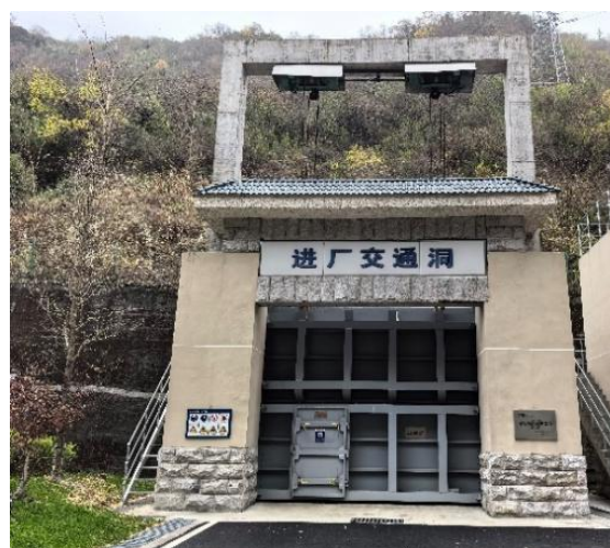
图 2 木座电站进厂交通洞防洪设施
