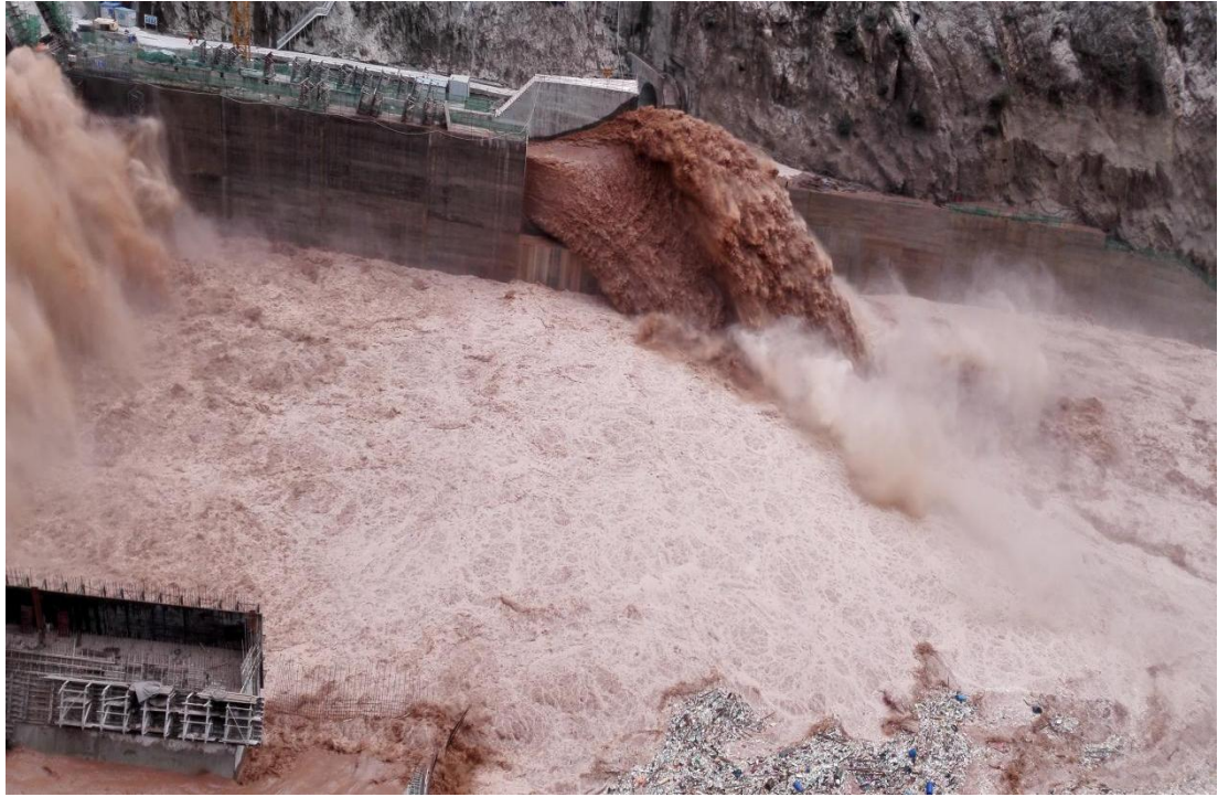
图 4 某在建工程底孔与坝体缺口联合泄洪
