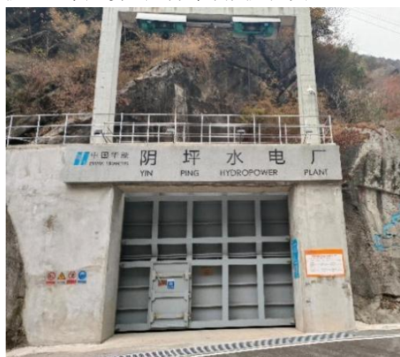
图 1 阴坪电站进厂交通洞防洪设施
