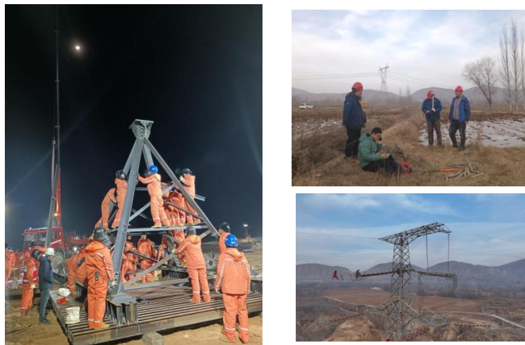
图2 750千伏官熙二线电力抢修
