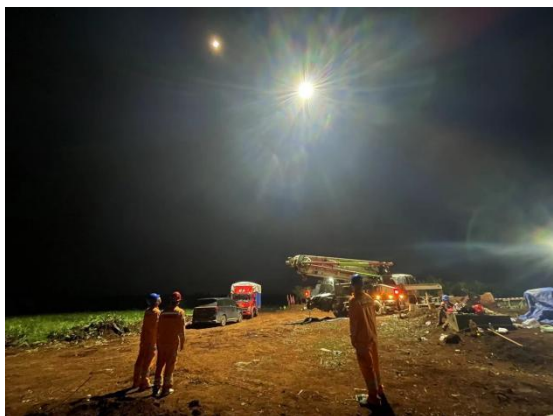
图 7 110kV 东旗线系留照明无人机提供夜间照明
