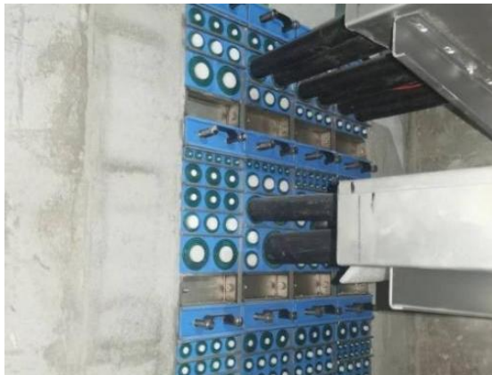
图 6 电缆模块封堵
