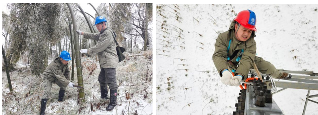
图 12 及时消除输电通道树（竹）障和各类设备缺陷
