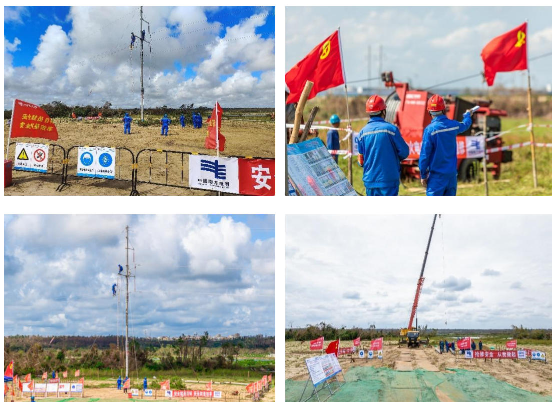
图 4 安全、高效、规范化的抢修现场
