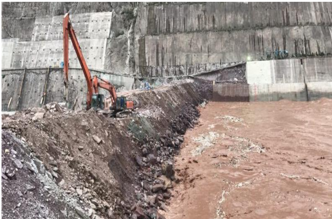
图3 某在建工程紧急加固基坑围堰
