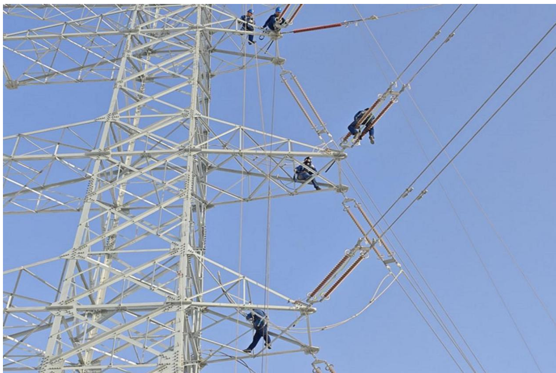
图 3 国网新疆电力有限公司对 220 千伏曼白线开展抢修工作
