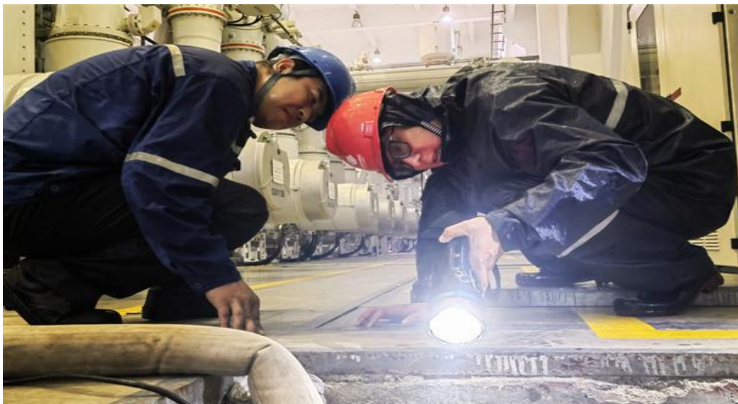
图 2 维护人员检查 GIS 排水井情况
