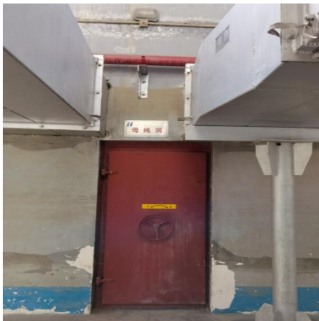
图 9 阴坪母线洞防洪门
