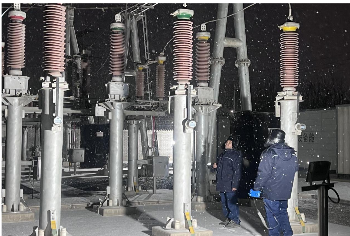
图 2 国网新疆电力有限公司员工开展变电站震后特巡
