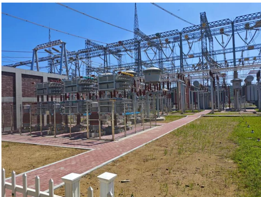
站区扩建场地撒播草籽（2024.08）
