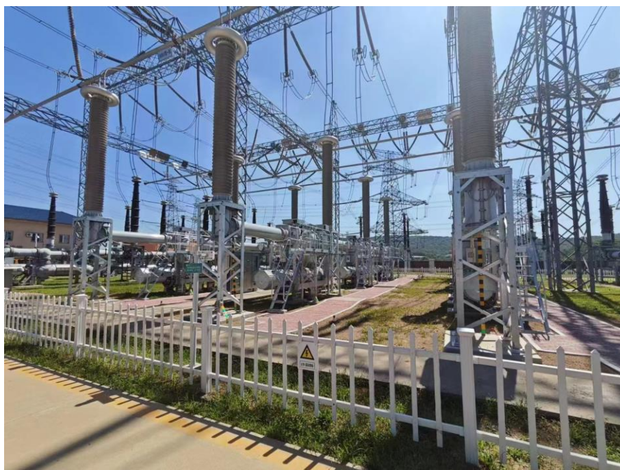
站区扩建场地撒播草籽（2024.08）
