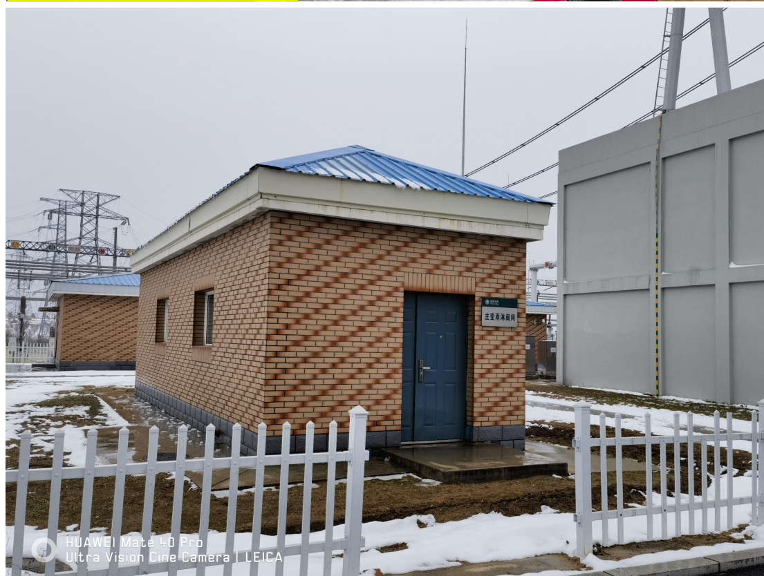
图 3-4 沈东变电站站内设施
