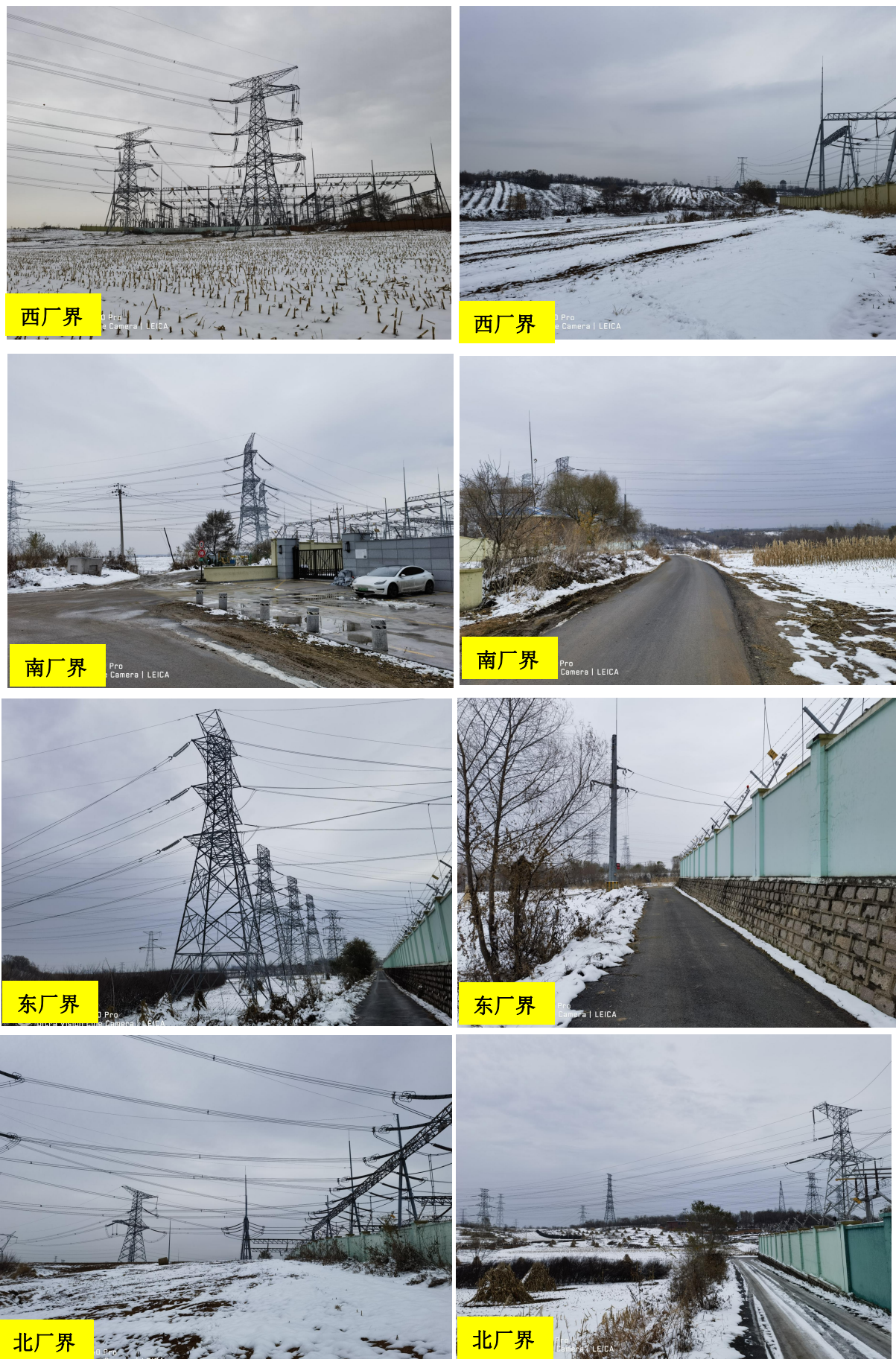
图 3-3 沈东变电站厂界周围
