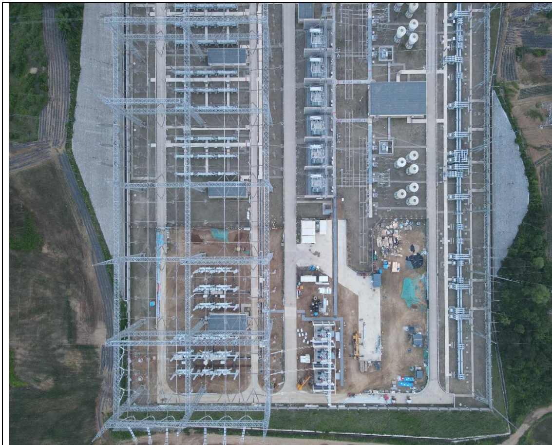
抚顺变电站扩建
