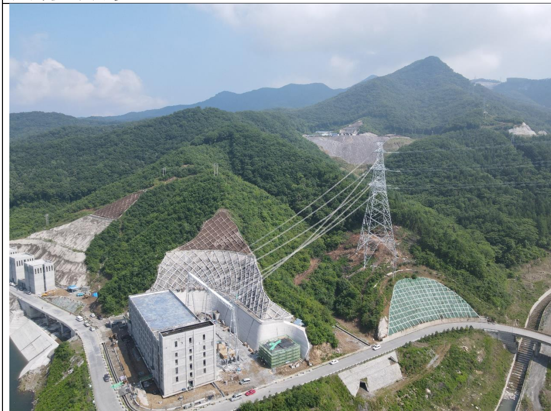
入抽蓄变塔基
