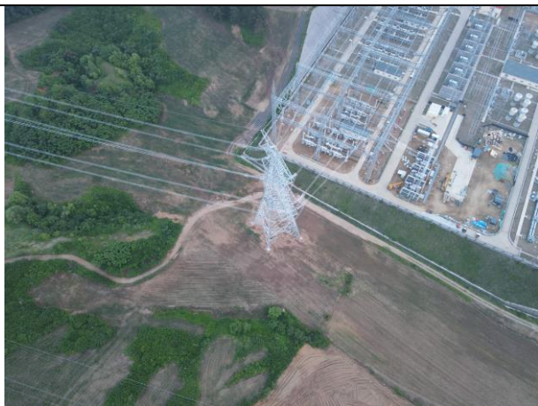
奥维定位、1号抚顺变出线
