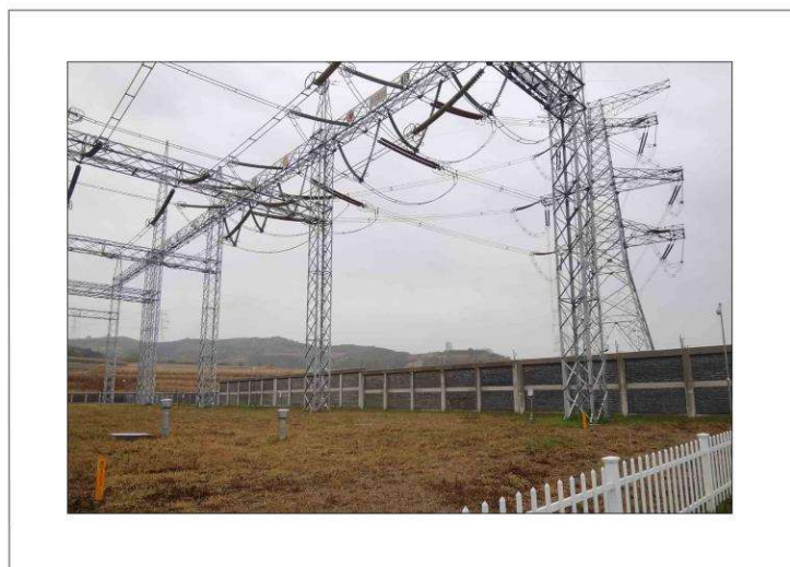
图11.1 析木500kV变电站事故油池照片
