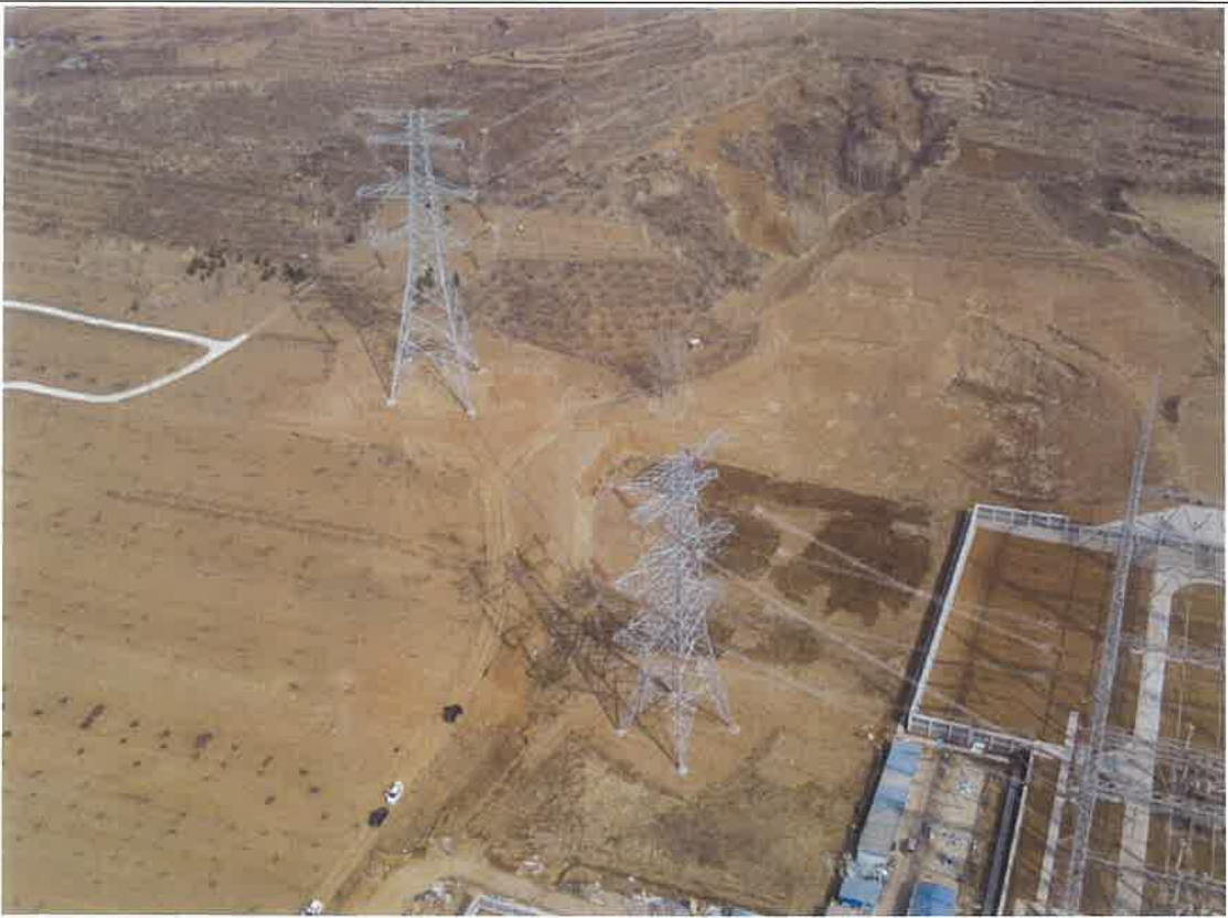
北侧出线 1+2 号塔
