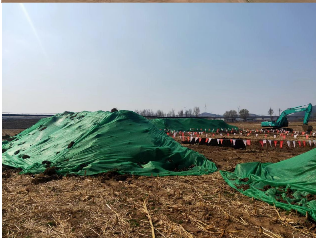
阜新至川州变线路工程区施工现场
